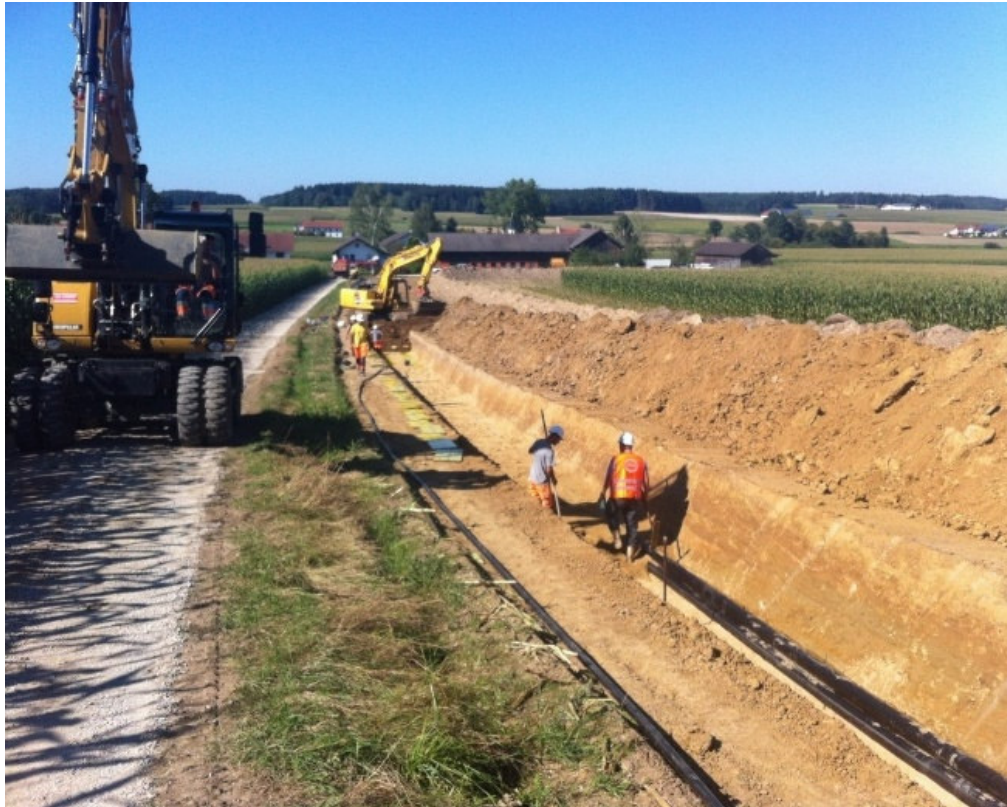
Abb. 3.10: Wanderbaustelle: täglich 300 m Ausheben, Installieren und Wiederverfüllen Kabelgraben 1,75 m tief, Breite 1,60 m am Boden und 2,50 m OE https://www.bayernwerk-netz.de/de/bayernwerk-netz-gmbh/netzausbau/erdkabelprojekte.html
