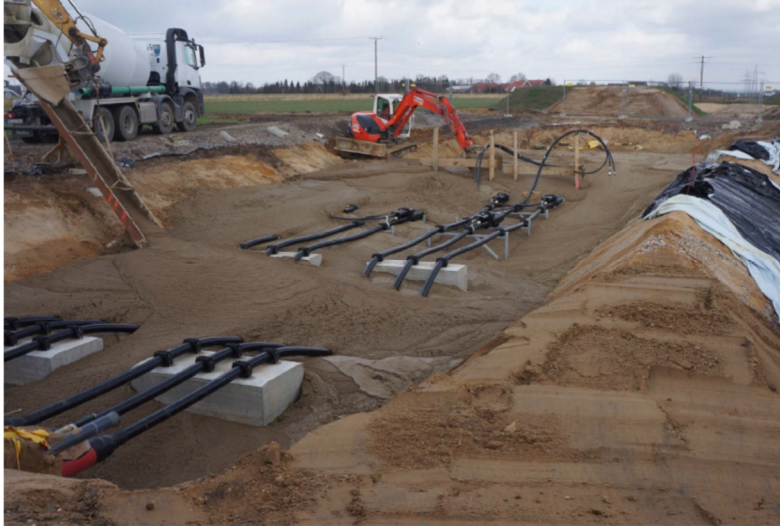
Abb. 4.3: Beispiele zu einer 380-kV-Trasse mit vier Kabelsystemen; Amprion; Raesfeld, 2015
