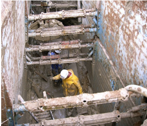
Abb. 5.15: Installation eines 220-kV-Kabels in Lübeck/Bad Schwartau; hier Bau eines Muffenschachtes mit rd. 5 m Tiefe
