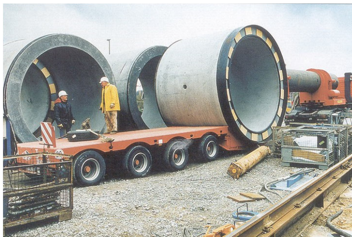
Abb. 5.21: Anlieferung eines Vortriebsrohres (DN 3200, Länge 3,00 m, Gewicht 35 t) auf einem Spezial-Rohrtransporter
