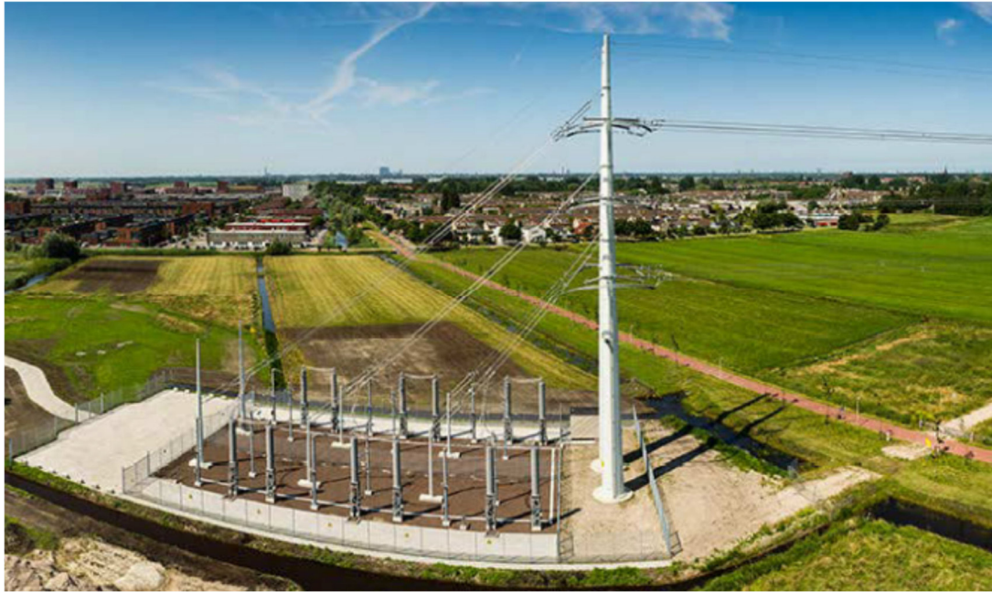
Abb. 6.3: 380-kV-Verkabelung im Südring Amsterdam (Randstatt), Übergang vom Doppel-Mast (Wintrack) mit zwei OHL-Systemen auf zwölf Kabeladern (Quelle: Tennet, K. Jansen: „Underground cables in the 380kV network“, 31. Jan. 2014, München)
