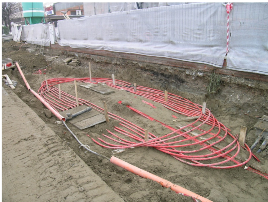
Abb. 7.2: Kompensationsleiter im Muffenbereich einer Kabelanlage (Quelle: Prysmian)
