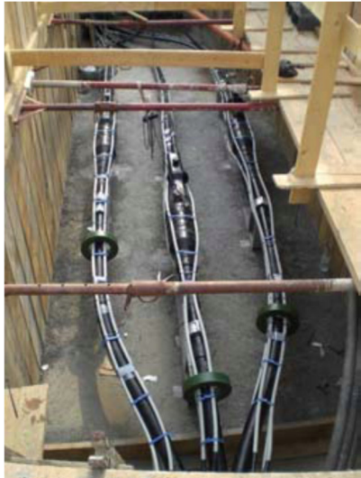
Abb. 7.3: Muffenbereich mit Kompensationsleitern (Quelle: A. Canova, ELF-EMF 2011, Paris)
