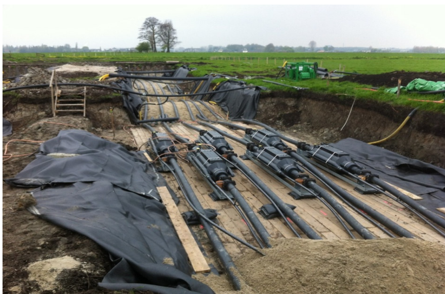
Abb. 3.5: Muffenbereich eines Kabeldoppelsystems (Quelle: IFK GmbH, ovag Netz)
